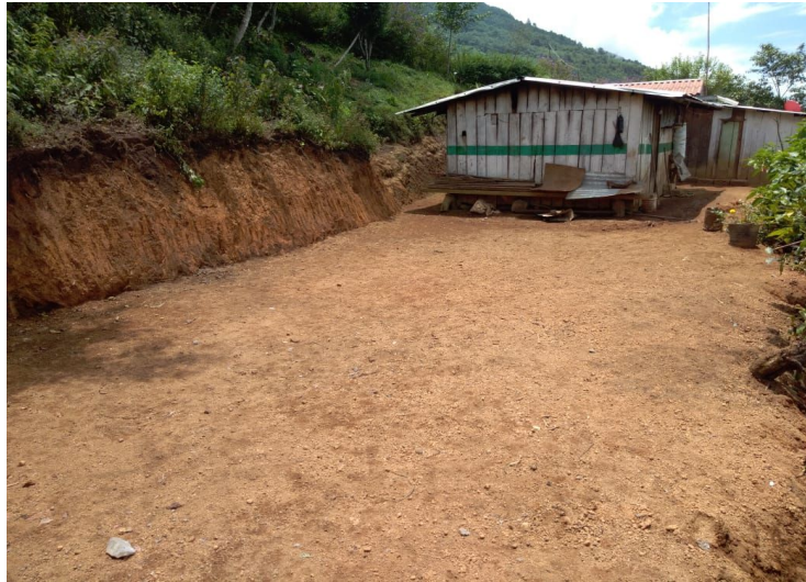
FOTO Limpia Trazo y Nivelación
