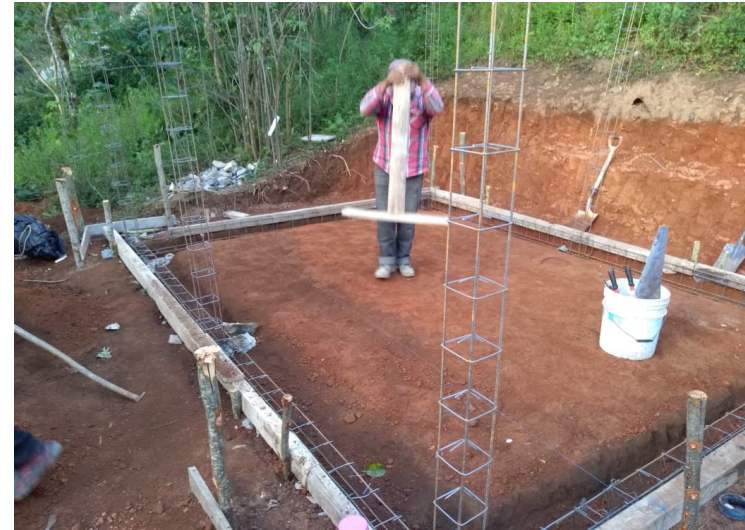
FOTO Limpia Trazo, Nivelación, desplante de estructuras, etc.
