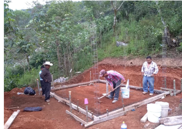
FOTO Limpia, Trazo y Nivelación
